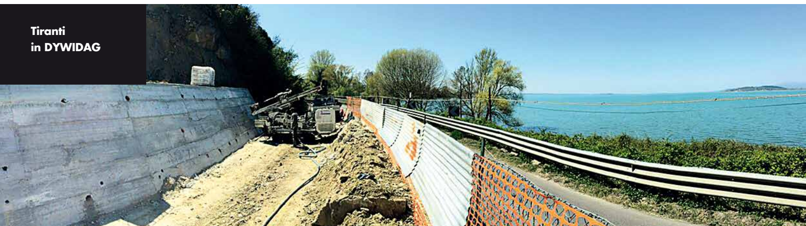
Pali trivellati Ø 600 Bordighera (IM)
