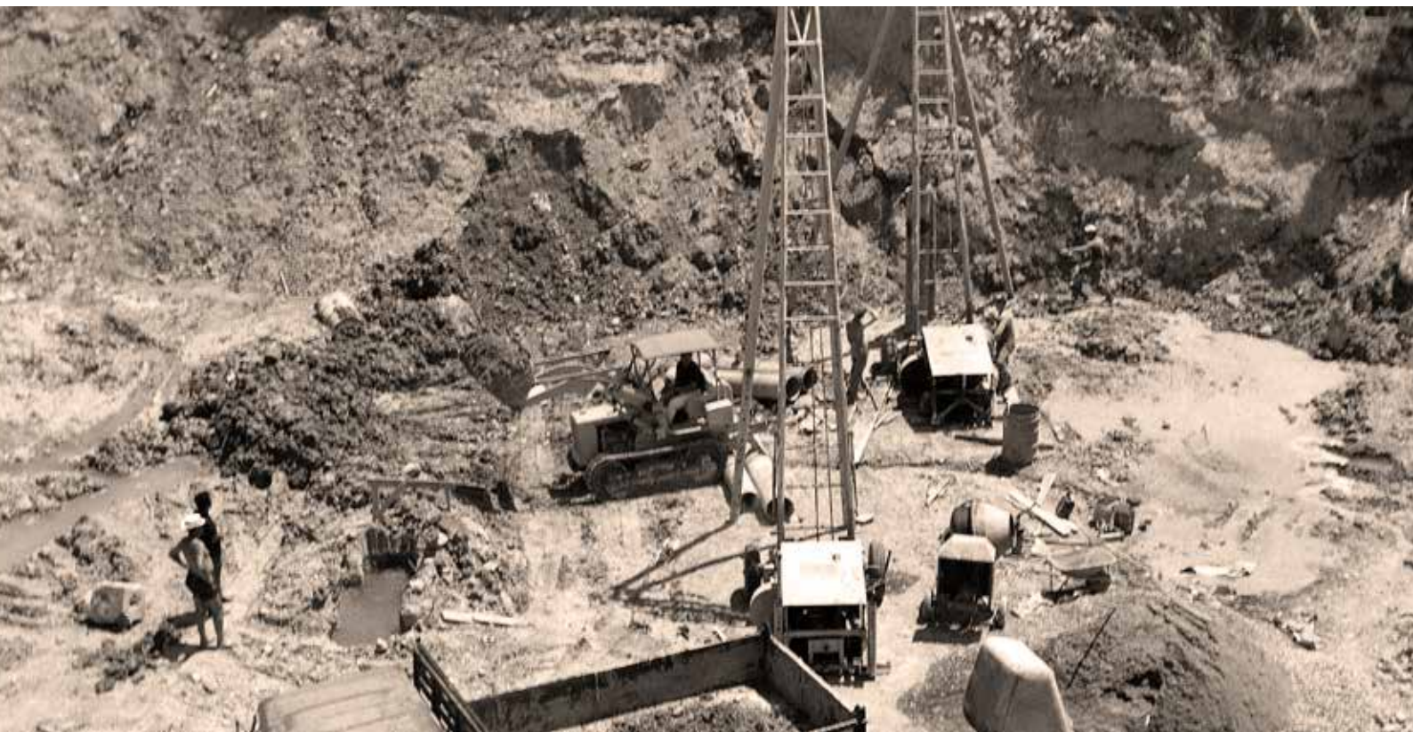
1965, Fondazioni chiesa Sant'Antonio - Fontivegge (PG)
